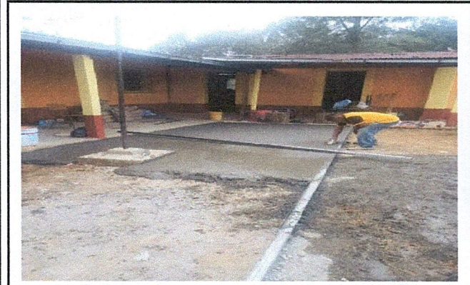
Foto 1: Mejoramiento de losa de patio
