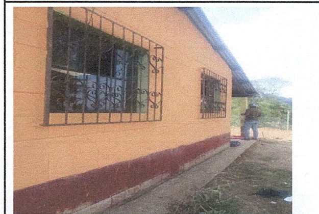
Foto 4: Mejoramiento de pintura interior
