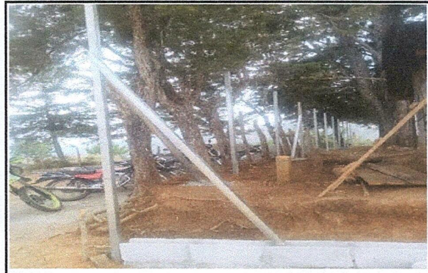
Foto 2: Mejoramiento de cerco perimetral
