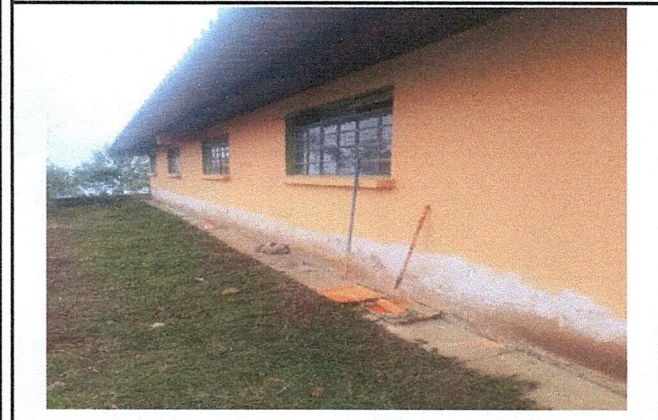
Foto 3: Mejoramiento de pintura exterior
